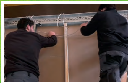
Einziehen von Kabeln
